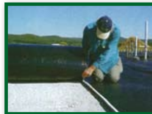
2. Sceller les joints à l'aide du ruban auto-collant breveté par NOFP
