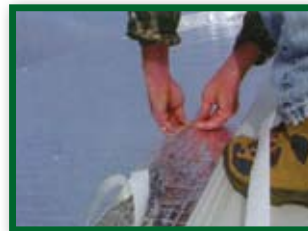
Ruban auto-collant pour joints breveté par NOFP
