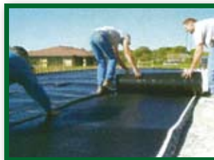
1. Dérouler le rouleau de 4' x 60' de mousse flexible EPS
