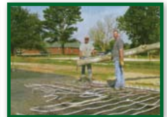
3. Couler le béton directement sur la surface
